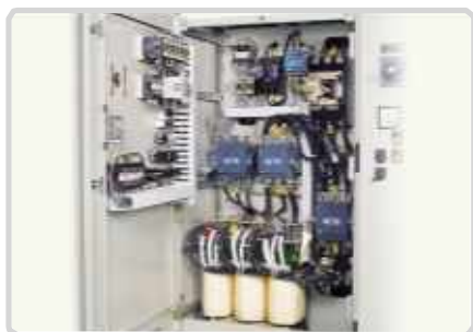
Элементы внутри шкафа
